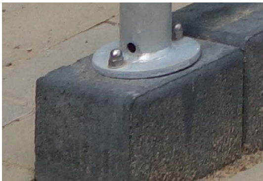
Montage Geländer auf Palisade
