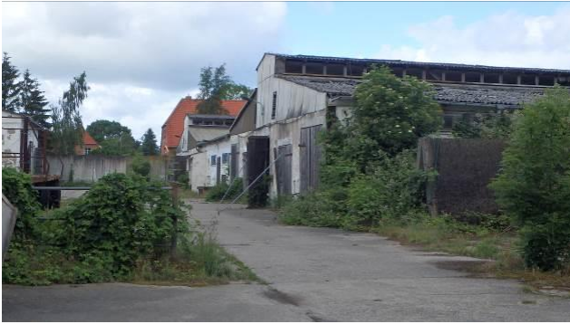
Plangebietsfläche in Richtung Westen mit angrenzender Bebauung der Ortslage am Wohnmobilstellplatz.
